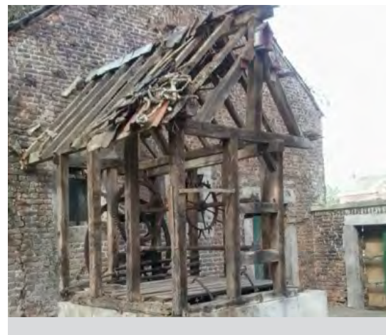
Puits et fournil. Première exploration du puits.
