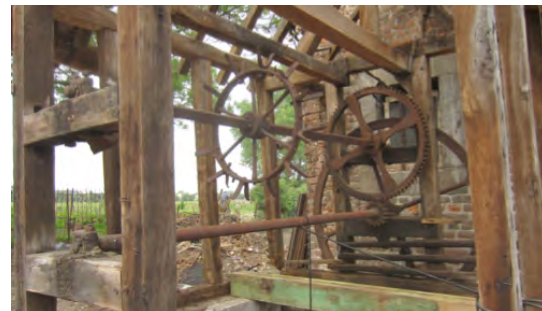
Le puits en cours de restauration. Il a été débarrassé du lierre qui le recouvrait totalement. La charpente en chêne a été partiellement remplacée, ainsi que la toiture. Le mécanisme (inventé par Blaise Pascal) est encore opérationnel, mais il manque la chaîne à picots et les fûts.
