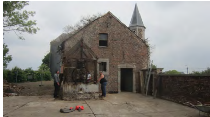
A l'avant-plan le puits avec sa charpente de chêne, avant rénovation. Le fournil comporte un étage où l'on a accès par un escalier en bois. Le four à pain (pas visible sur cette photo) est à l'arrière du bâtiment. La gueule du four se trouve à l'intérieur du fournil.
