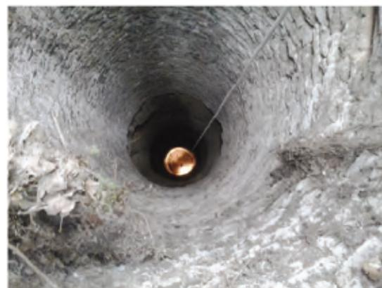
Le puits n'est cuvelé que sur les premiers mètres. Après l'argile à silex, il traverse apparemment une loupe de sable, puis s'enfoncé dans la craie. La base, dans le tuffeau, est rectiligne et tout à fait stable.
